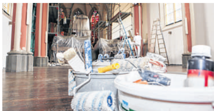
Auch Malerarbeiten wurden vorgenommen.
